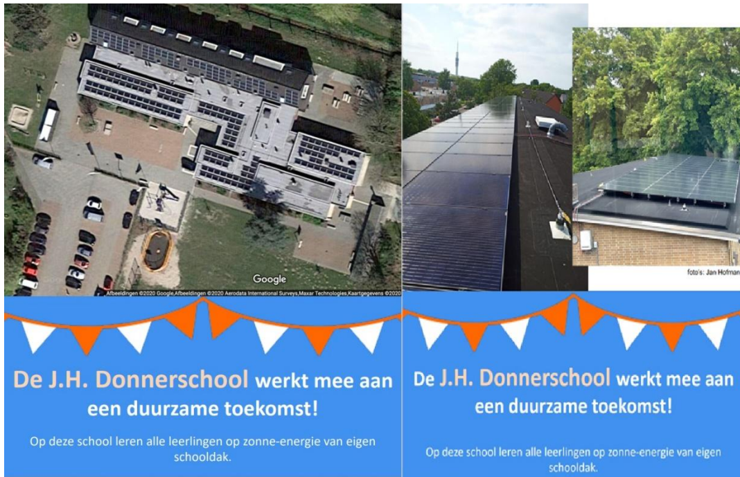
Figuur 49: Beide locaties zijn voorzien van zonnepanelen!
